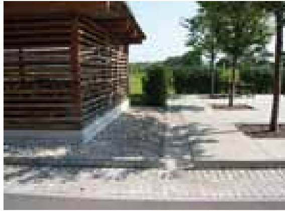
SolarCity Linz: Dezentrale Versickerung des Regenwassers in angrenzenden Vegetationsflächen (Foto: Schumacher, 2009)
