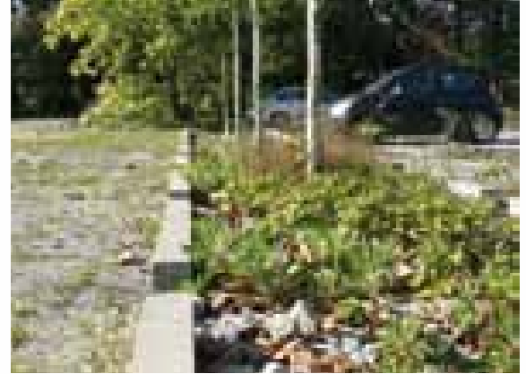
Parkplatz der FH Erfurt, Standort Leipziger Str. 77: Der Pflanzstreifen dient gleichzeitig als Sickermulde für Regenwasser (Foto: Sieber 2009)
