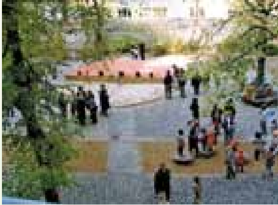
Minimierung der Bodenversiegelung: Wechsel von wassergebundener Wegedecke und recyceltem Großpflaster: Schulhof der Wilhelm-Wander-Schule (Almut Krause, Vortrag »Schulhofgestaltung: Ein Praxisbericht - Spiel. Raum. Planung Leipzig«, FH Erfurt 2009)
